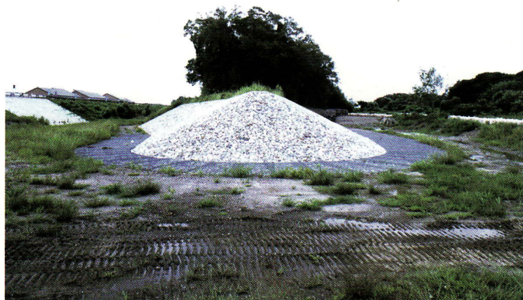
[タブ林は残った 中の島に残ったタブ林と改修状況]
